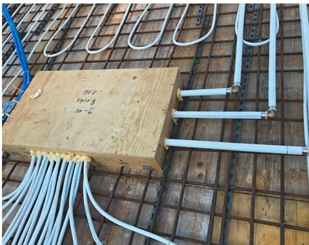
**[FIG. 3]** Esempio di una scatola da incasso per distributori TABS.
